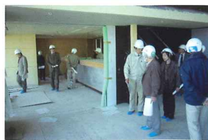
理事工事現場視察
