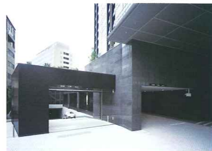
地下駐車場出入口
