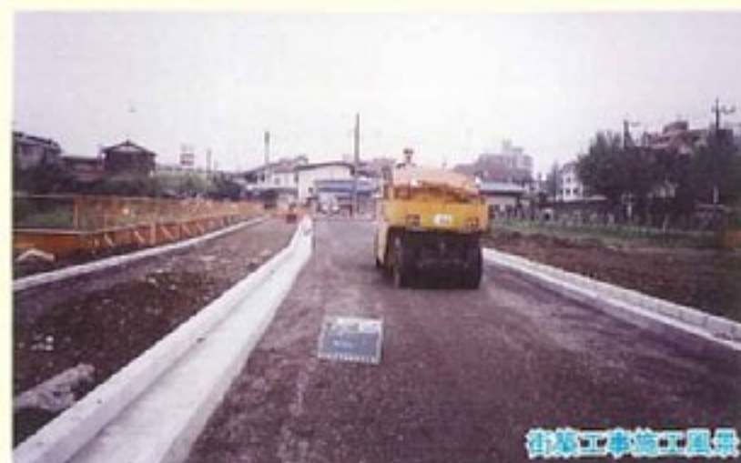
街築工事施工風景
