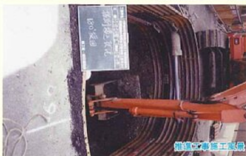
推進工事施工風景
