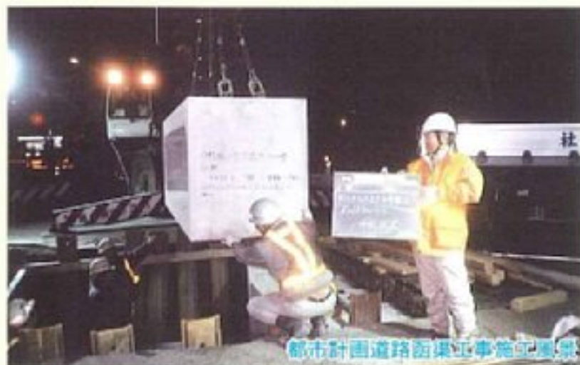
都市計画道路歩道舗装工事施工風景
